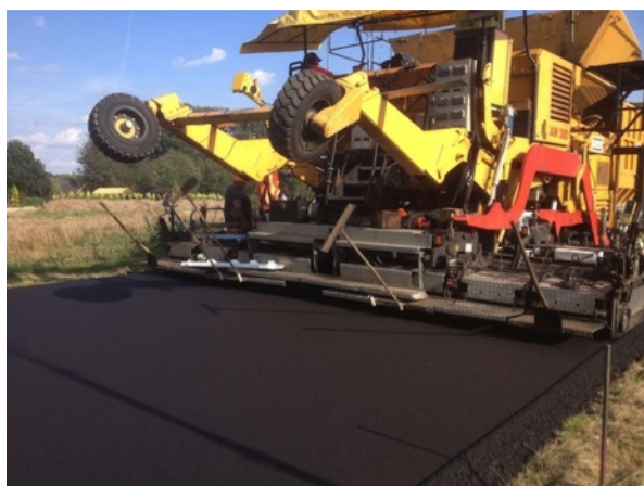
Bild 79: Einbau an der B68
