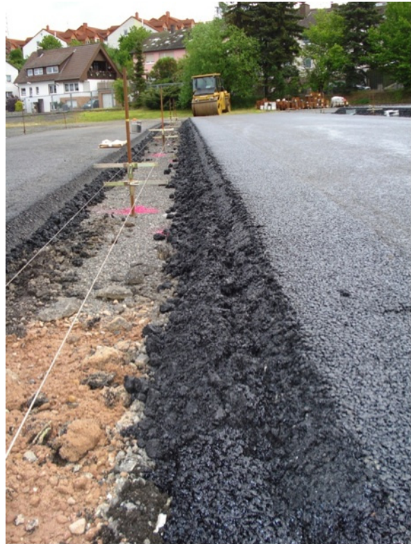
Bild 44: Ungleichmäßiges Kantenbild an den dicken Kompaktasphaltaufbauten (rechts) ggü. typischer Kantenverdichtung am 12 cm – Referenzfeld (links)
