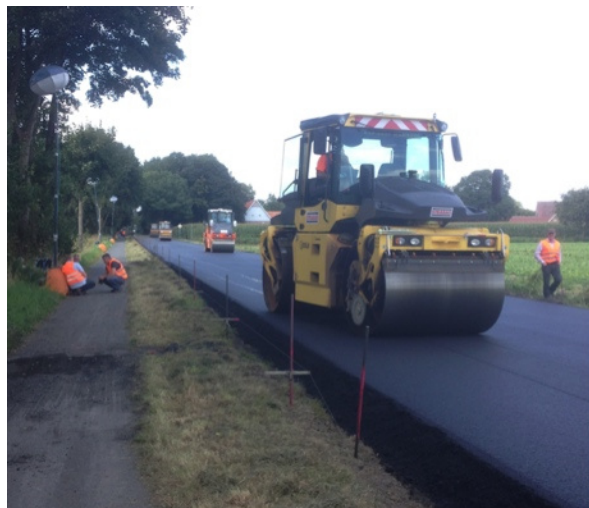
Bild 80: Walzverdichtung an der B68
