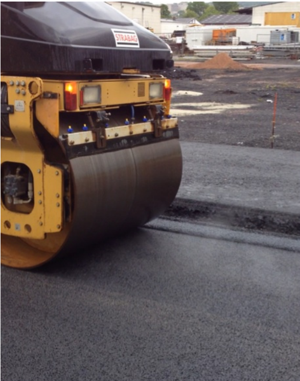
Bild 42: Erhöhtes Einsenkmaß bei dynamischem Walz- übergang am modifizierten Kompaktasphalt
