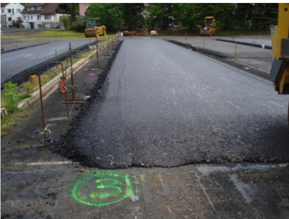
Bild 43: Deckschicht von Versuchsfeld 3 (mod. Kompakt- asphalt 22+2 cm) nach der Walzverdichtung
