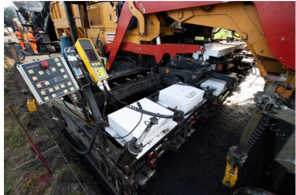
Bild 76: Bohlenauflastung an der Tragschichtbohle des Kompaktasphaltfertigers beim BV B68
