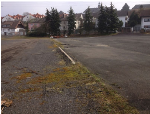
Bild 32: Baufeld für die vorgesehenen Versuchsfelder mit ungebundener Unterlage (links) und gebundener Unterlage (rechts) vor der Vorbereitung
