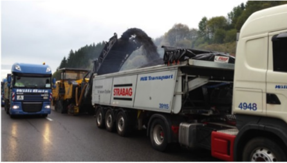
Bild 106: Fräsen nach Taktplan an der BAB 96 [SAT, 2014]
