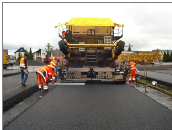
Bild 41: Deckschicht von Versuchsfeld 3 (mod. Kompaktasphalt 22+2 cm) vor der Walzverdichtung
