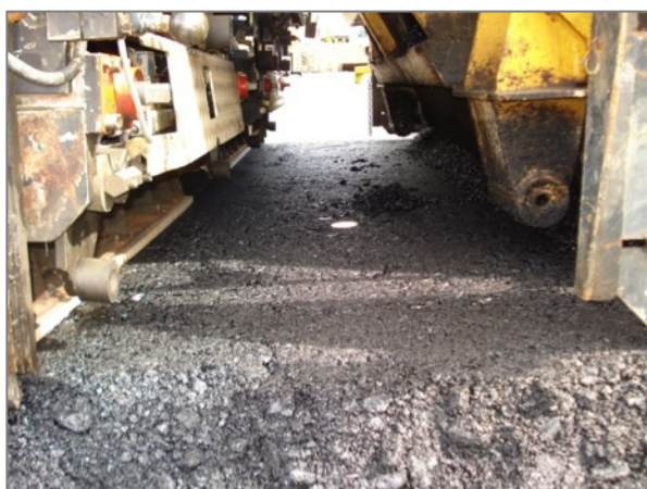
Bild 40: Oberfläche der Binder-/Tragschicht von Versuchsfeld 3 (mod. Kompaktasphalt 22+2 cm) vor der Deckschichtbohle
