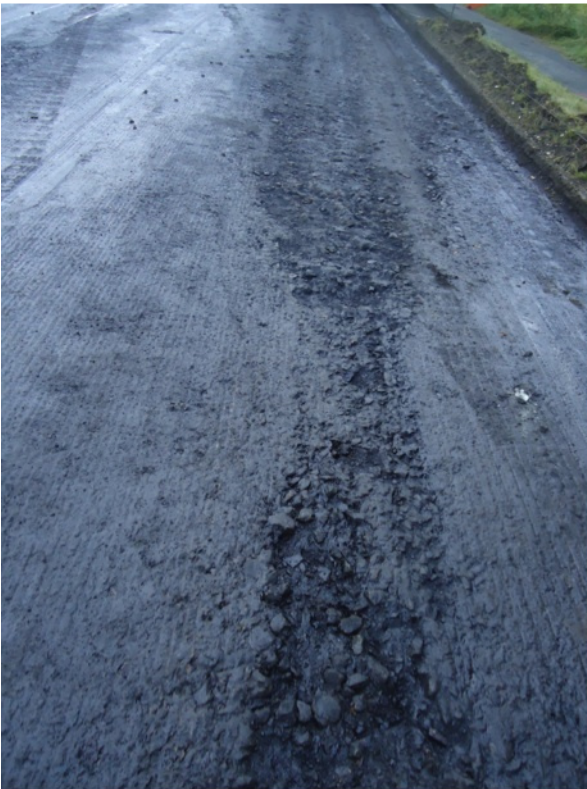
Bild 75: Beispiel für die heterogene Beschaffenheit der Unterlage beim BV B68
