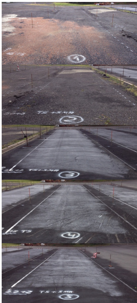
Bild 37: Angewalzte und mit Bitumenemulsion angesprühte Unterlagen der Einbaufelder 1-6 (von oben nach unten)
