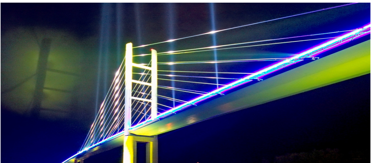
Bild 4: Rügenbrücke (Foto: DEGES / René Legrand)
