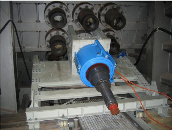
Bild 16: Lösen der Stützmutter am Spannanker [6]
