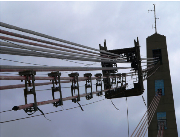
Bild 17: Ablassen eines Seilstücks
