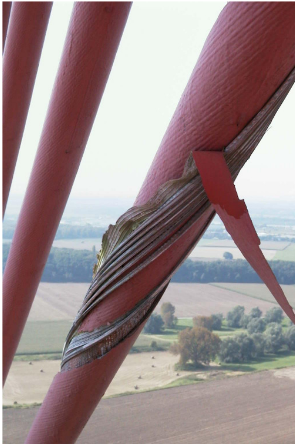
Bild 15: Offene Drahtbrüche
