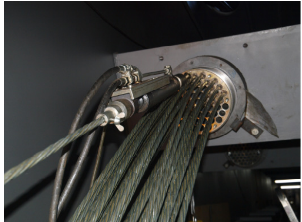
Bild 31: Spannen mit einer Monolitzenpresse
