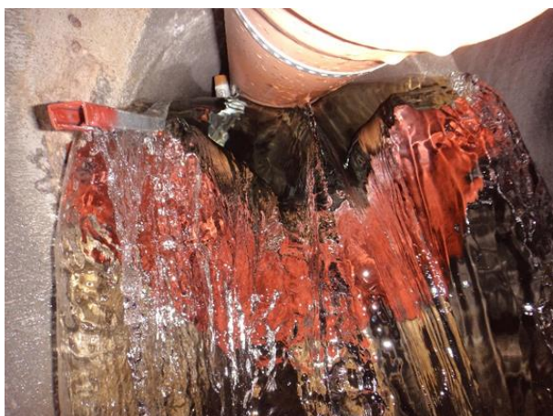
Abbildung 3: Überströmtes Messwehr DN 500 am Südportal
