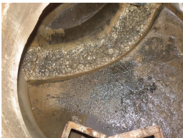
Abbildung 18: Blick in Schacht D1
