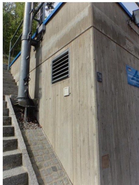
Abbildung 1: Außenfassade des Tunnelbetriebsraums
